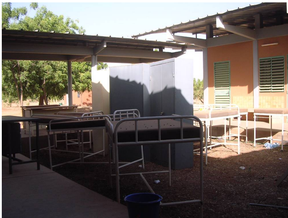
Photo 5 : Tables d'accouchement de l'initiative PPTE
